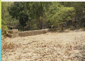
砂防ダムは水と一緒に流れる土砂をせき止める役割を担う
